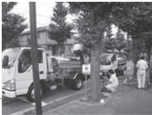
7月14日(水)からの集中豪雨により、飯田市では一部の水源 地が濁水となり、浄水場で水道水が作れない状態となりま した。豊橋市は「三遠南信災害時相互応援協定」に基づき、7 月16日(金)に給水車1台と職員2人を飯田市へ派遣しました。 現地では他市からの応援隊とともに消火栓から配水池への 上水のピストン輸送を行いました
