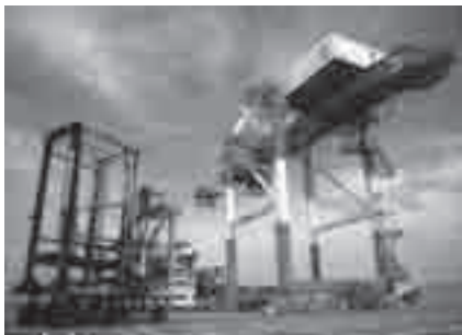
ガントリークレーン
