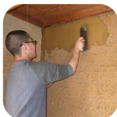
▲本格的な土壁塗り
