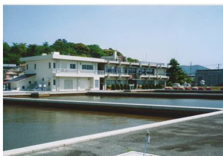
小鷹野浄水場
