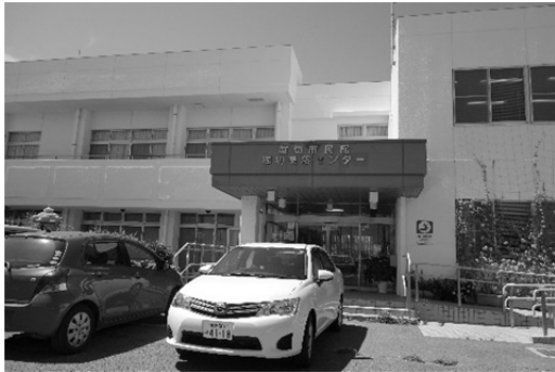
堀切市民館（堀切集落センター）
