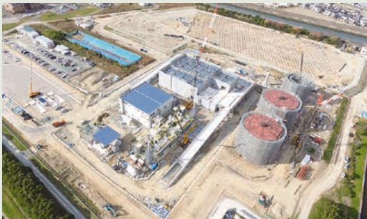
建設中のバイオマス利活用センター
