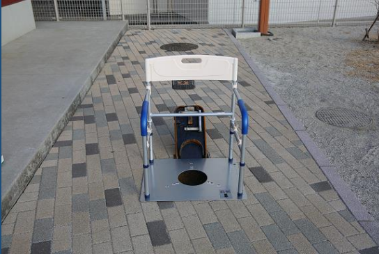
マンホールの蓋を開けます。
