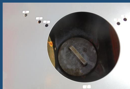
マンホールトイレとベースプレートの穴が重なるように、これを設置します。
