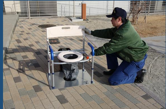
便器を設置します。このとき、便器のブーツをマンホールトイレの穴に確実に入れます。
