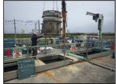
【老朽化した処理場の改築工事】
