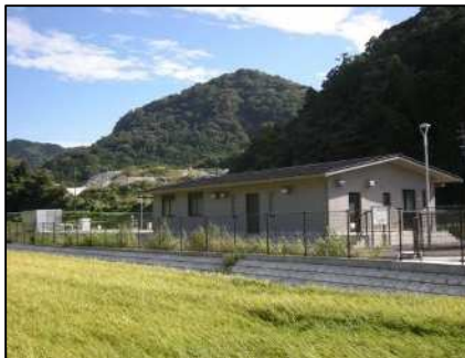
高山浄化センター
