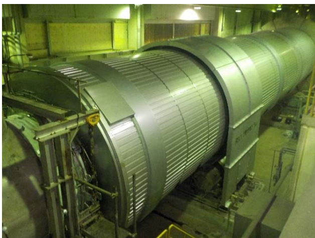
復旧工事完了後の熱分解ドラム
