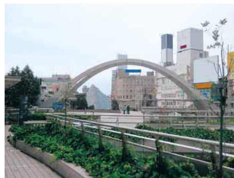
豊橋駅前ペDESTリアンデッキ
