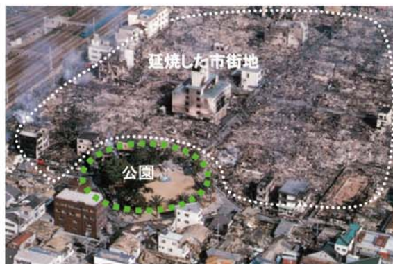
焼け止まりになった公園(阪神淡路大震災) 出典：防災公園計画・設計ガイドライン (財)都市緑化技術開発機構
