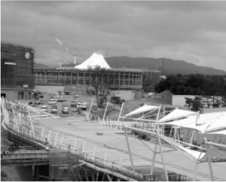
グローバル・ループの向こうに企業パビリオンの建設が進んでいます
