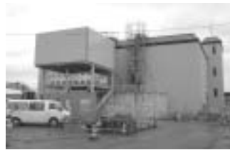
地下ポンプ場の建設工事
