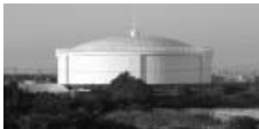
南都2号配水池
