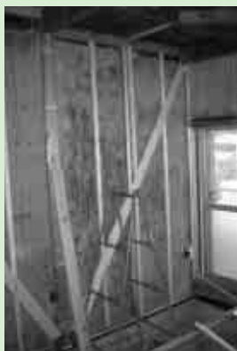
壁に入れた筋交い(窓をつぶさずに既設)
