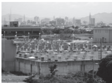
環境に配慮した方式で運転している中島処理場の新しい施設(分流施設)
