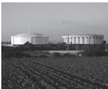
南部配水場のタンク
