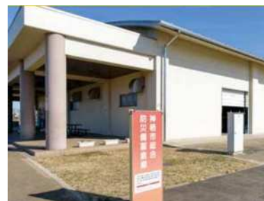
神栖中央公園内の防災備蓄倉庫
