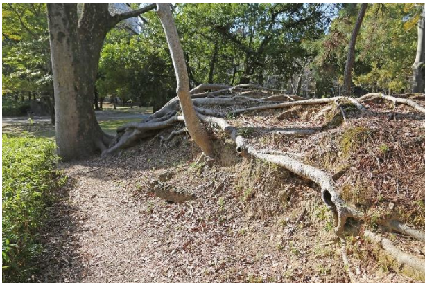
土砂が流出し樹根がむき出しになった土塁（二の丸）
