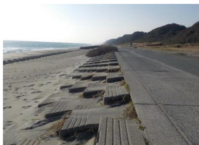
▽海岸保全施設（傾斜堤）
