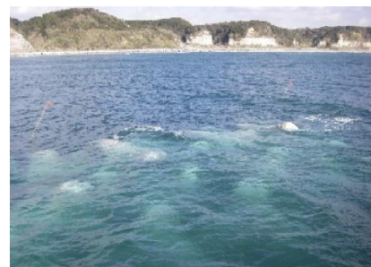
▽海岸保全施設（離岸堤）
