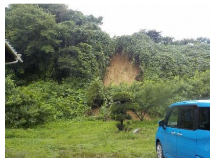
図 4-4 がけ崩れの様子(豊橋市)
