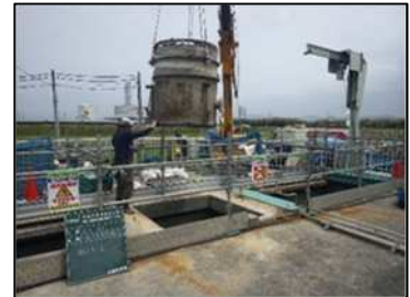
【老朽化した処理場の改築工事】
