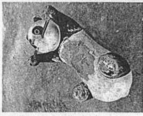
一部の遊具 経年劣化でびびわれなどが目立つ
