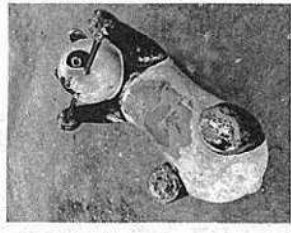
一部の遊具 経年劣化でひびわれなどが目立つ
