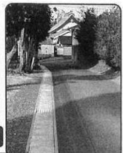
高師小学校南側の側溝新設
