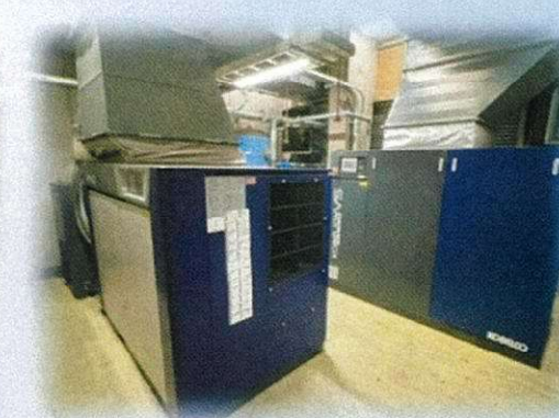
コンプレッサ設置
