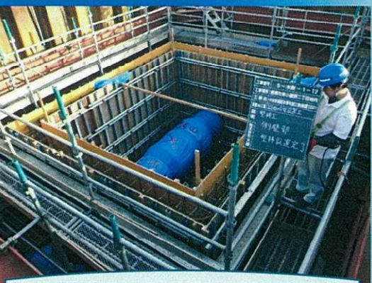
中央幹線配水管布設工事 (耐震 102)
