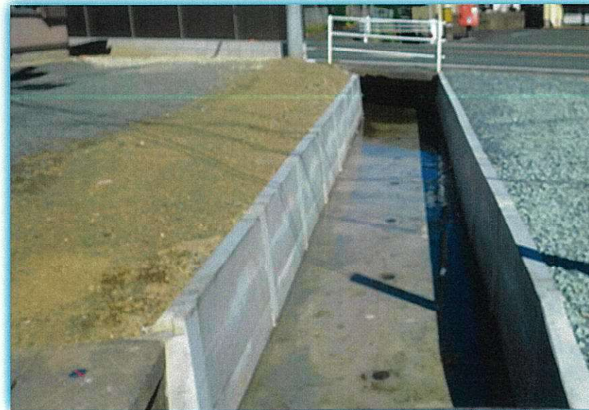
河川水路等維持整備工事4
