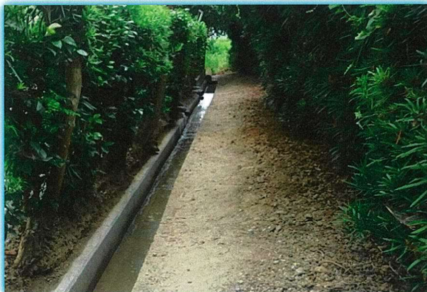
河川水路等維持整備工事2
