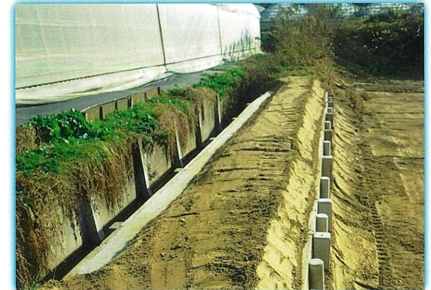
河川水路等維持整備工事9
