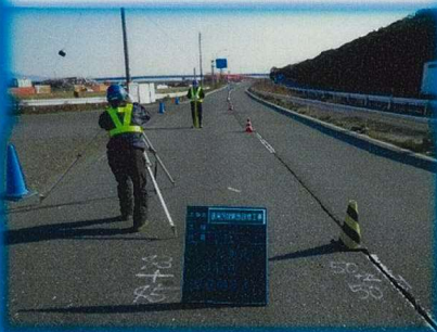
工事前の測量風景
