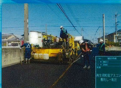
自社重機によるアスファルト舗装工事の施工状況(例)
