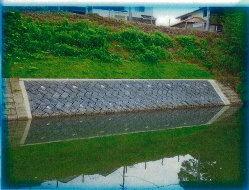
朝倉川の災害復旧工事
