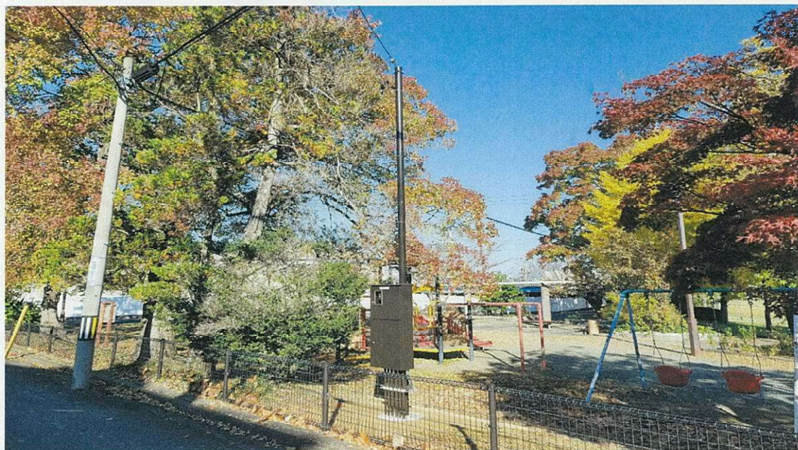
東田公園（引込柱、分電盤取替）
