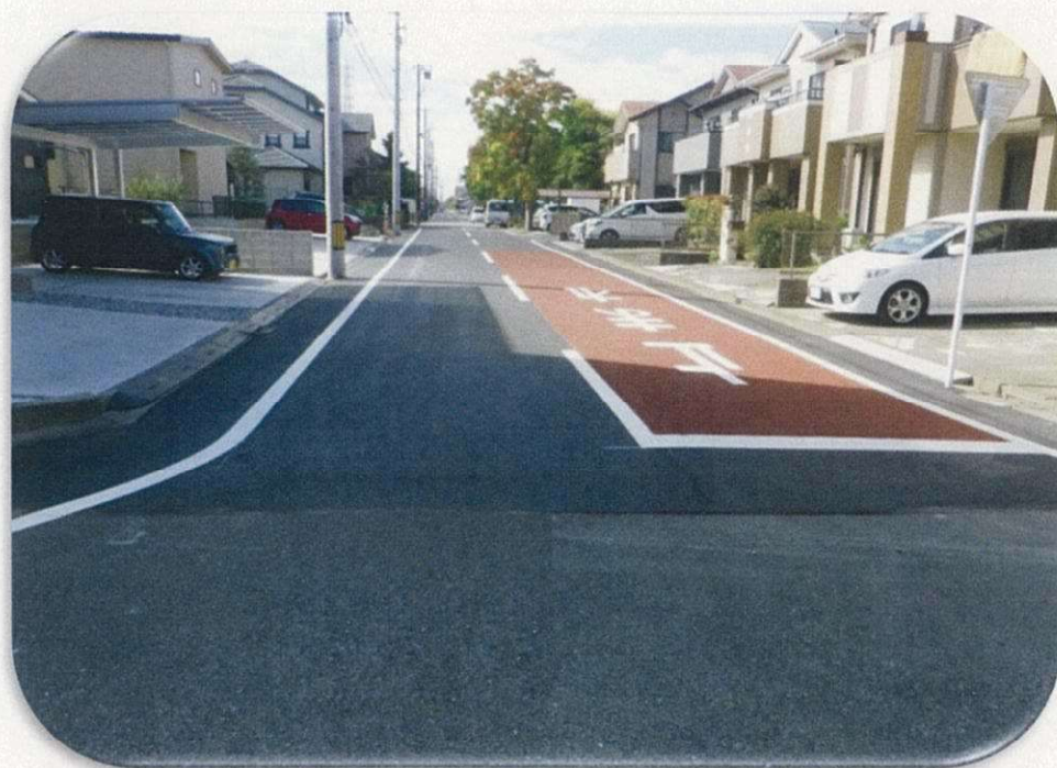
工事名 : 舗装修繕工事3
