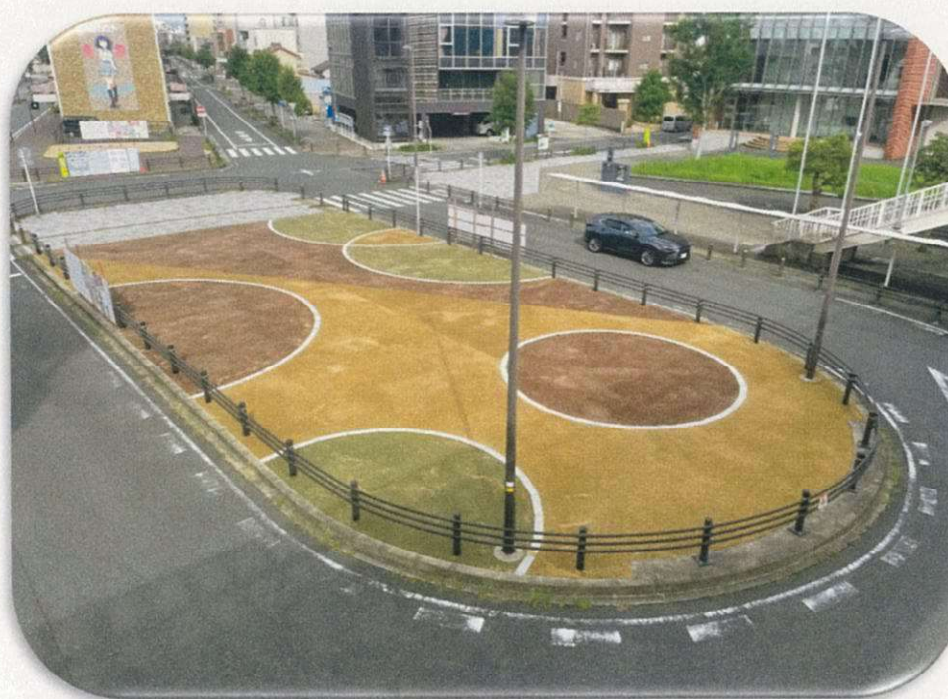
工事名 : デザイン舗装新設工事
