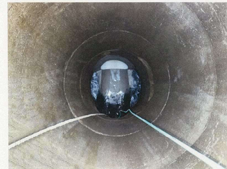
老朽管更生工事 2
