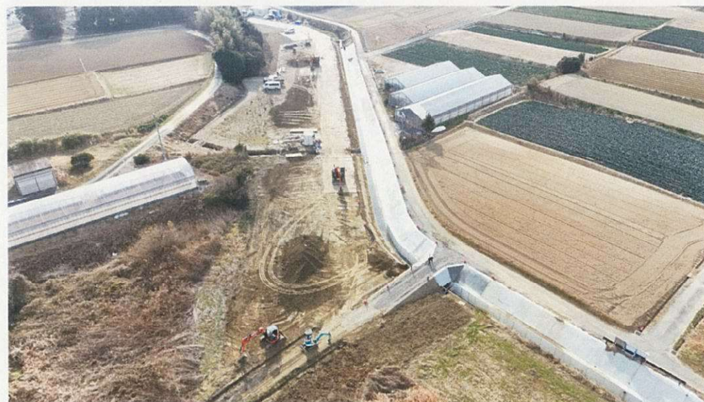
河川改良工事
