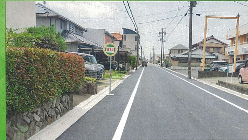
路面排水工事 7
