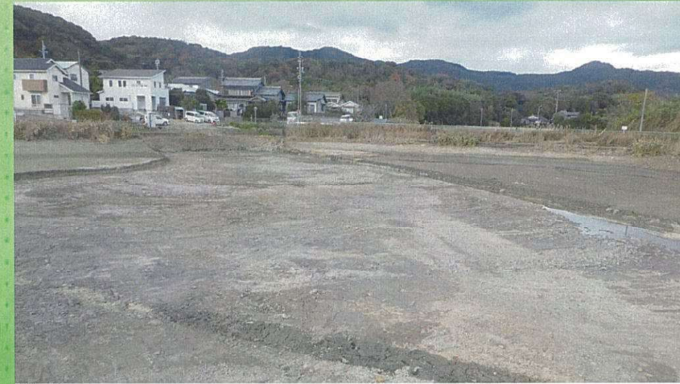
ため池 しゅんせつ 浚渫工事 6
