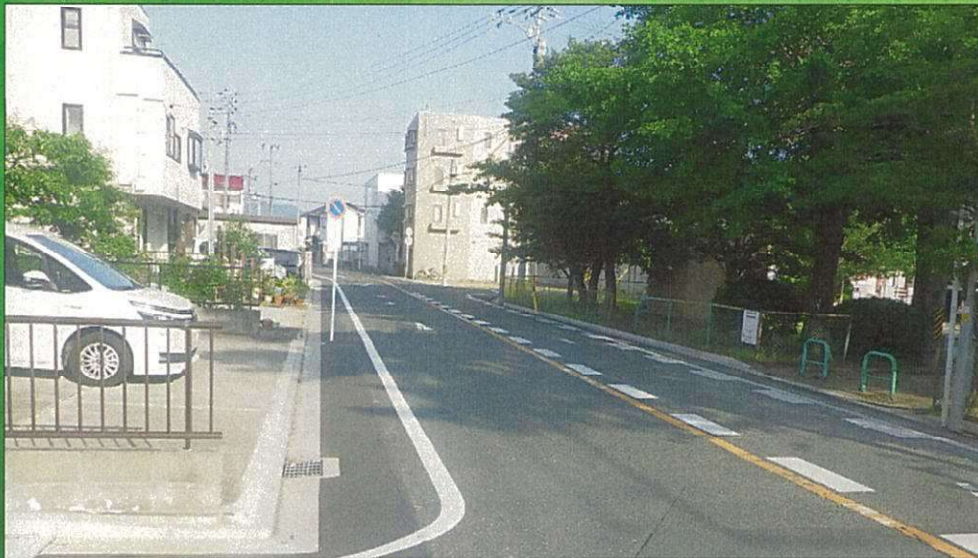
路面排水工事 3
