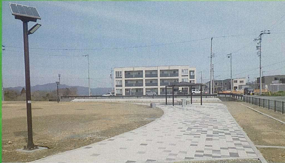
牛川洗島第一公園諸施設築造工事
