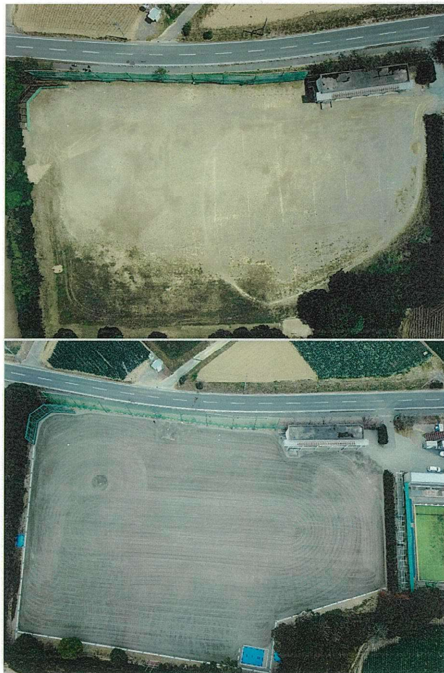
高豊中学校運動場改修工事 豊橋市東赤沢町地内
