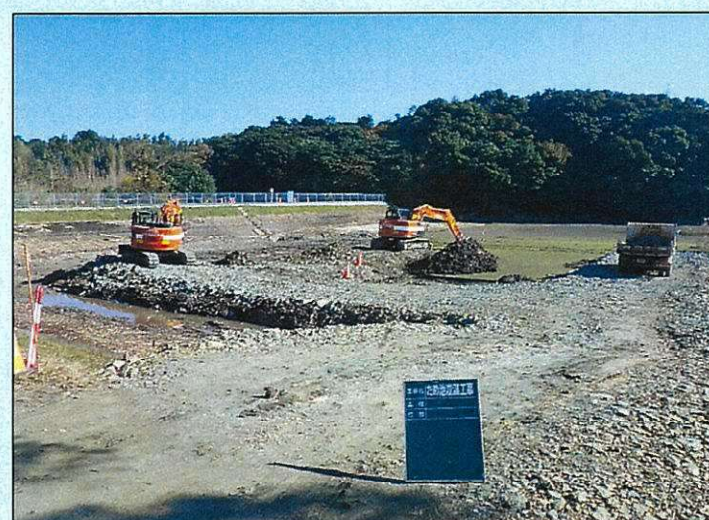
ため池浚渫工事 (植田町地内 精進池)
