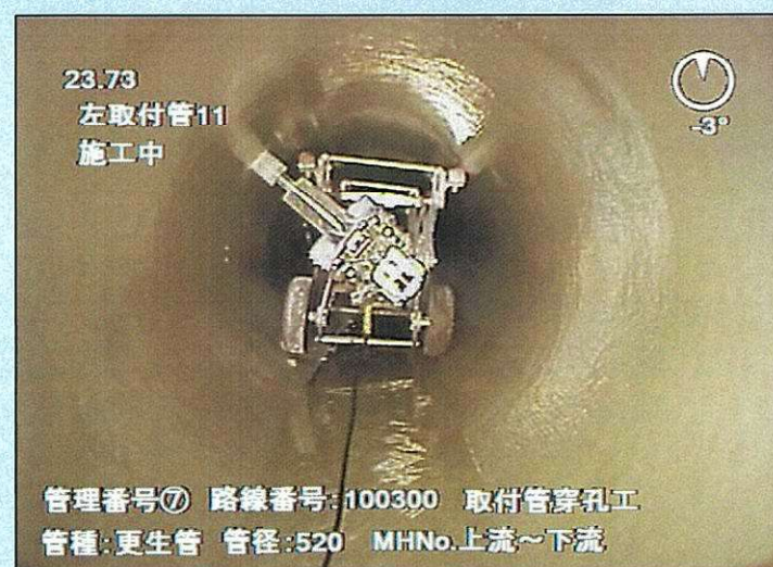
老朽管更生工事 (小口径下水道管耐震補強)
