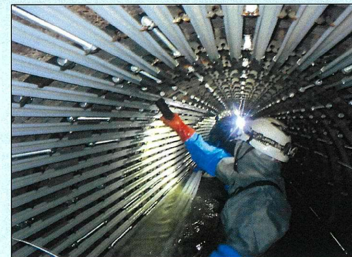
下水道管渠耐震工事 (大口径下水道管耐震補強)
