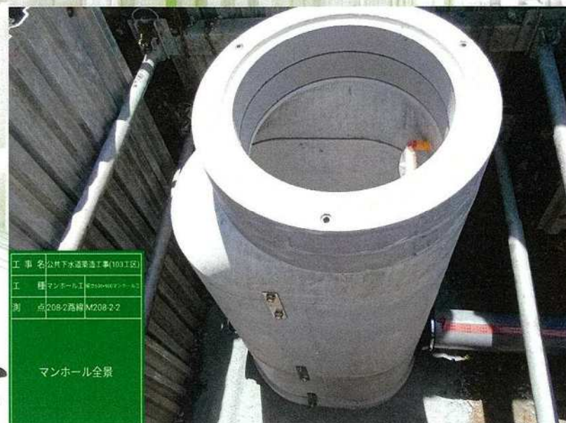
R7年度 公共下水道築造工事(103工区) 豊橋市牛川町地内(豊川流域関連処理区下地処理分区牛川地区) 下水道新設:組立マンホール工(組立600×900マンホール)設置
