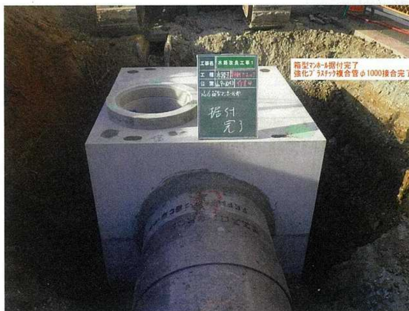
R7年度 水路改良工事1 豊橋市 西幸町地内ほか 水路工:箱型マンホール・強化プラスチック複合管
