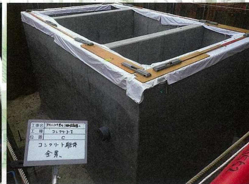
R7年度 民間工事:アイシンシロキ(株)豊川工場 豊川市 大木町地内 排水系統・処理改善工事(油水分離槽C)
