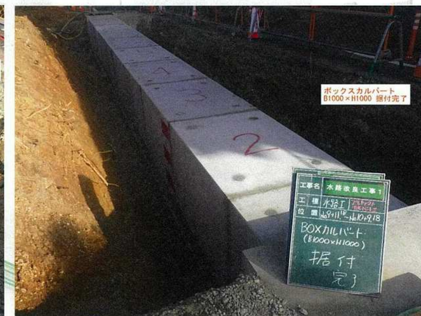
R7年度 水路改良工事1 豊橋市 西幸町地内ほか 水路工:プレキャストカバート工
