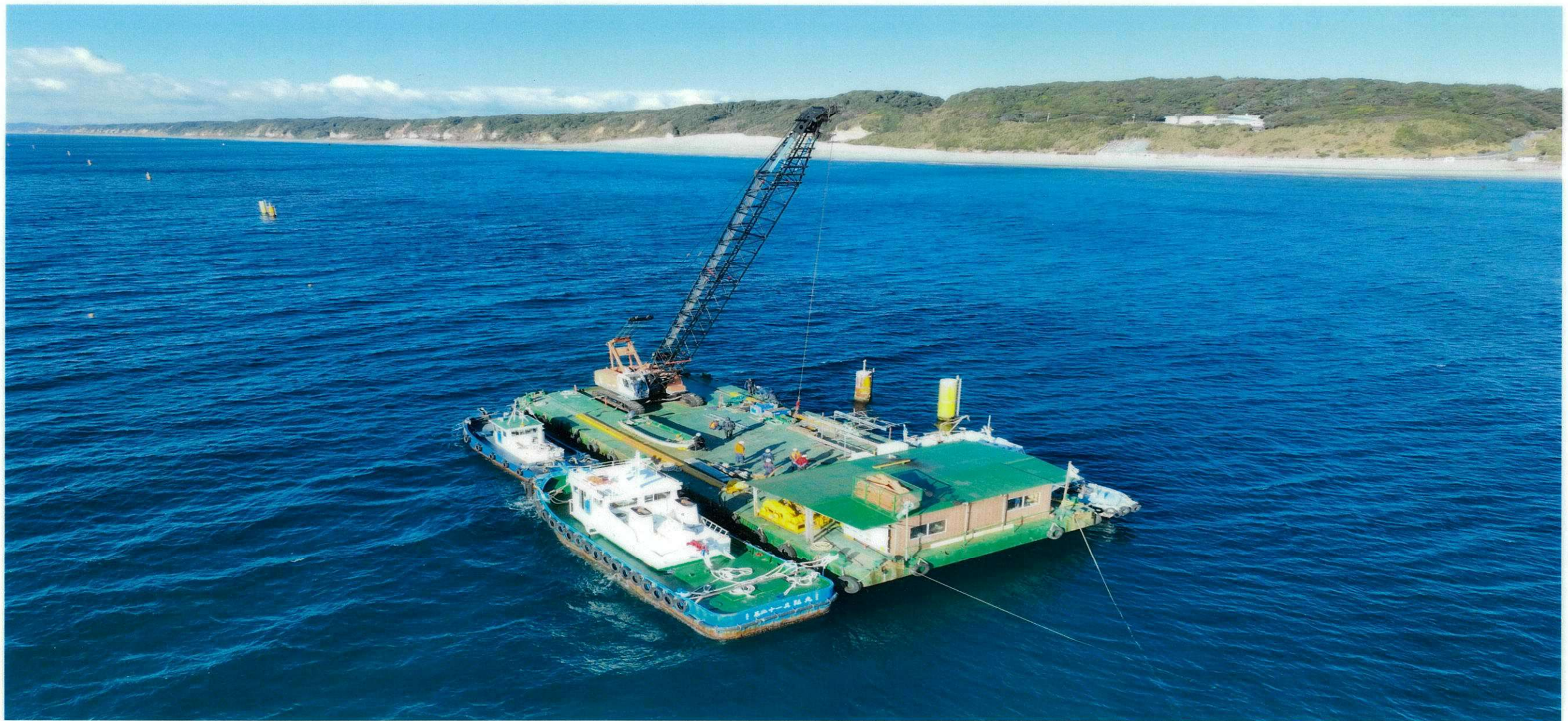
灯標改修工事
