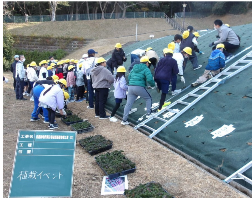
岩屋緑地西側広場植栽基盤整備工事（R7）
