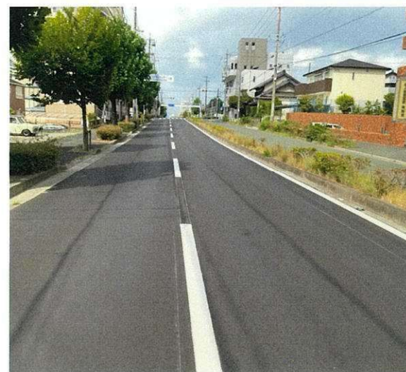
舗装改良工事（長寿命化）
