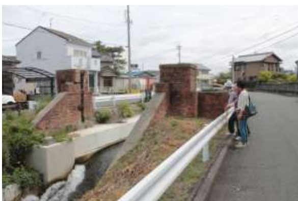
図 8-80 牟呂発電所跡
