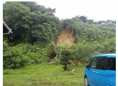
図 4-4 かけ崩れの様子(豊橋市)
