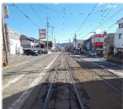
▲軌道敷改修前
