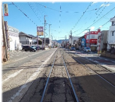
▲軌道敷改修前
