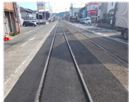
▲軌道敷改修後
