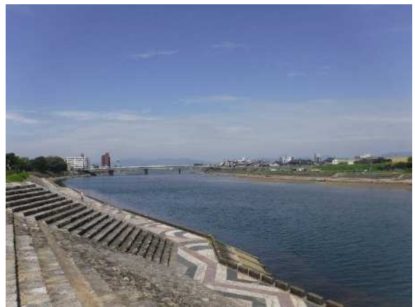
豊川下流域 吉田大橋付近 護岸
