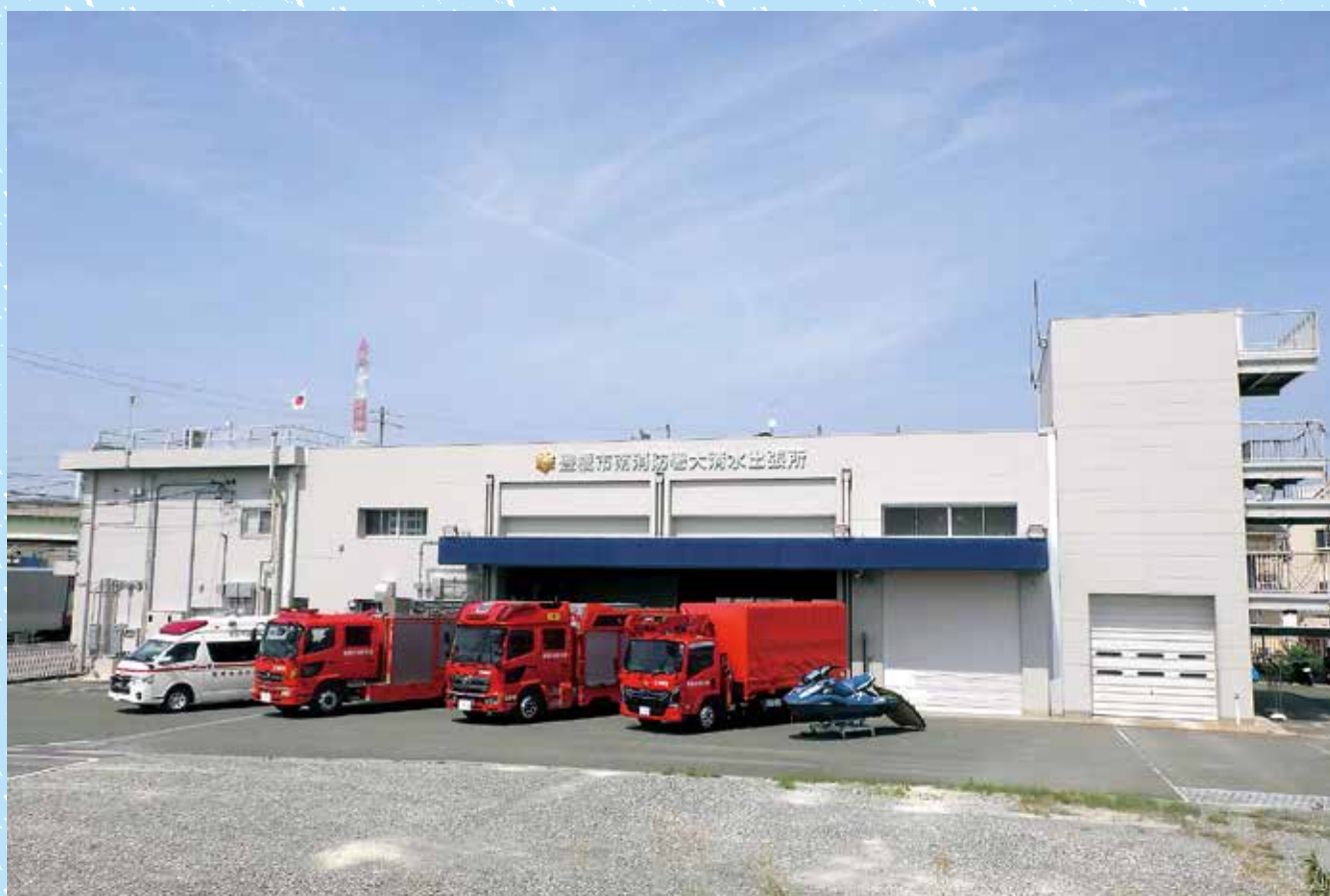
豊橋市南消防署大清水出張所
