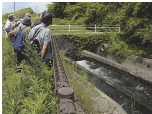
図 1-38 牟呂用水と樋管
