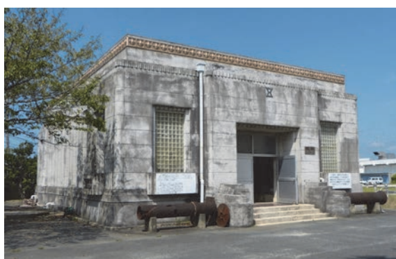
図2-3 豊橋市上水道施設小鷹野浄水場旧ポンプ室
