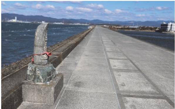
図 8-15 神野新田堤防と護岸観音
