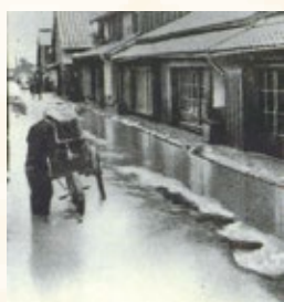
花田町地内のぬかるみ 『豊橋下水道史』より転載
