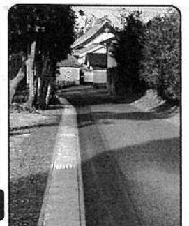
高師小学校南側の側溝新設
