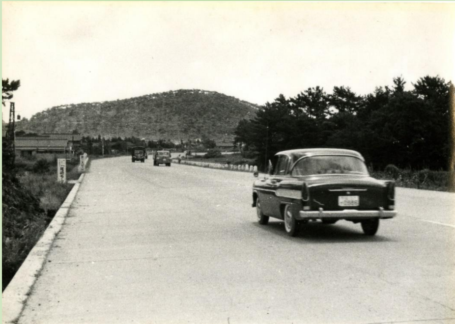
国道1号 撮影時期不明
