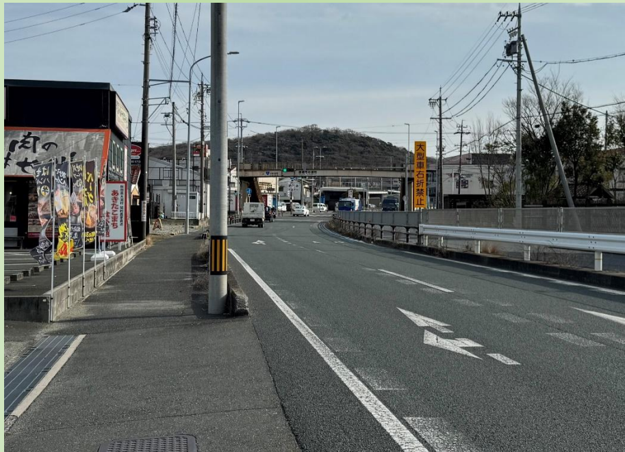
国道1号 撮影時期令和5年
