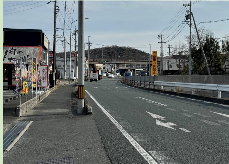
国道1号 撮影時期令和5年
