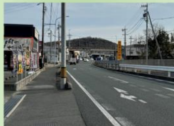
国道1号 撮影時期令和5年
