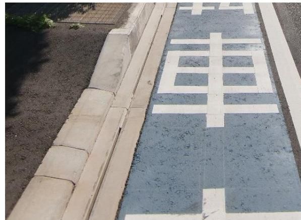
図25 自転車通行空間の整備と併せた側溝の整備の事例（静岡市）
